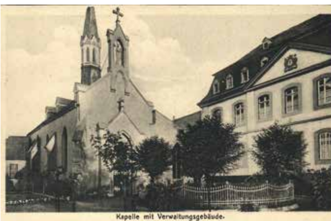
Kapelle mit Verwaltungsgebäude.
